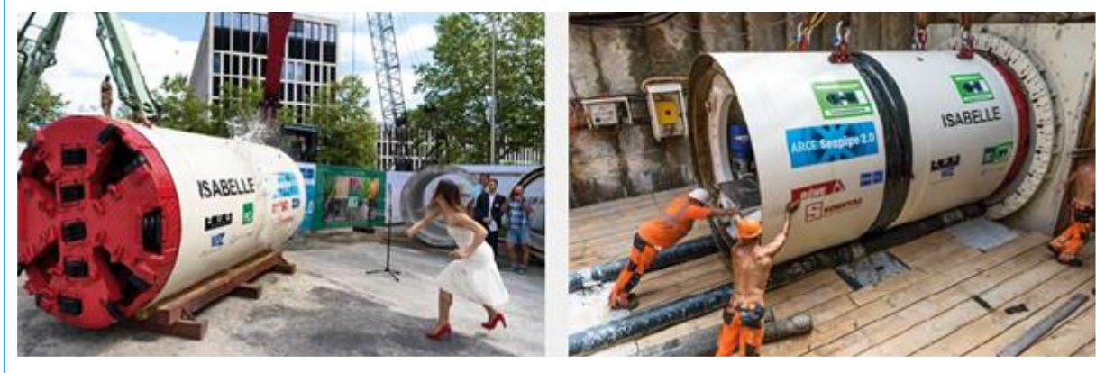
Abbildung 23: Links: der Vortriebsbohrer Isabelle. Rechts: Einbau des Bohrers im Startschacht (Tschan und Watts 2018)
