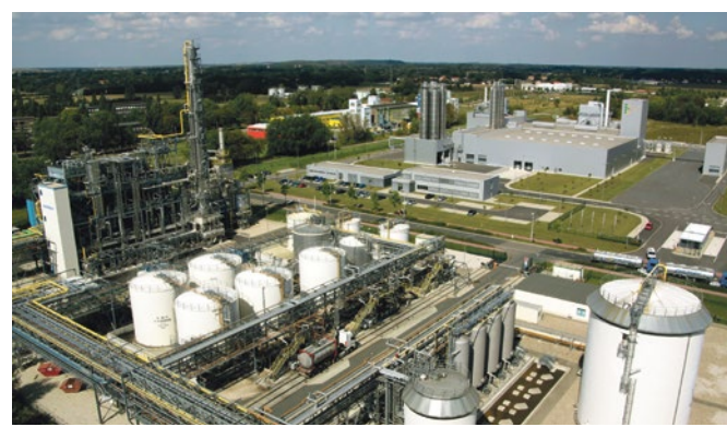
Puraglobe stellt in Zeitz aus Altöl neue Basisöle der höchsten Güteklasse her.
